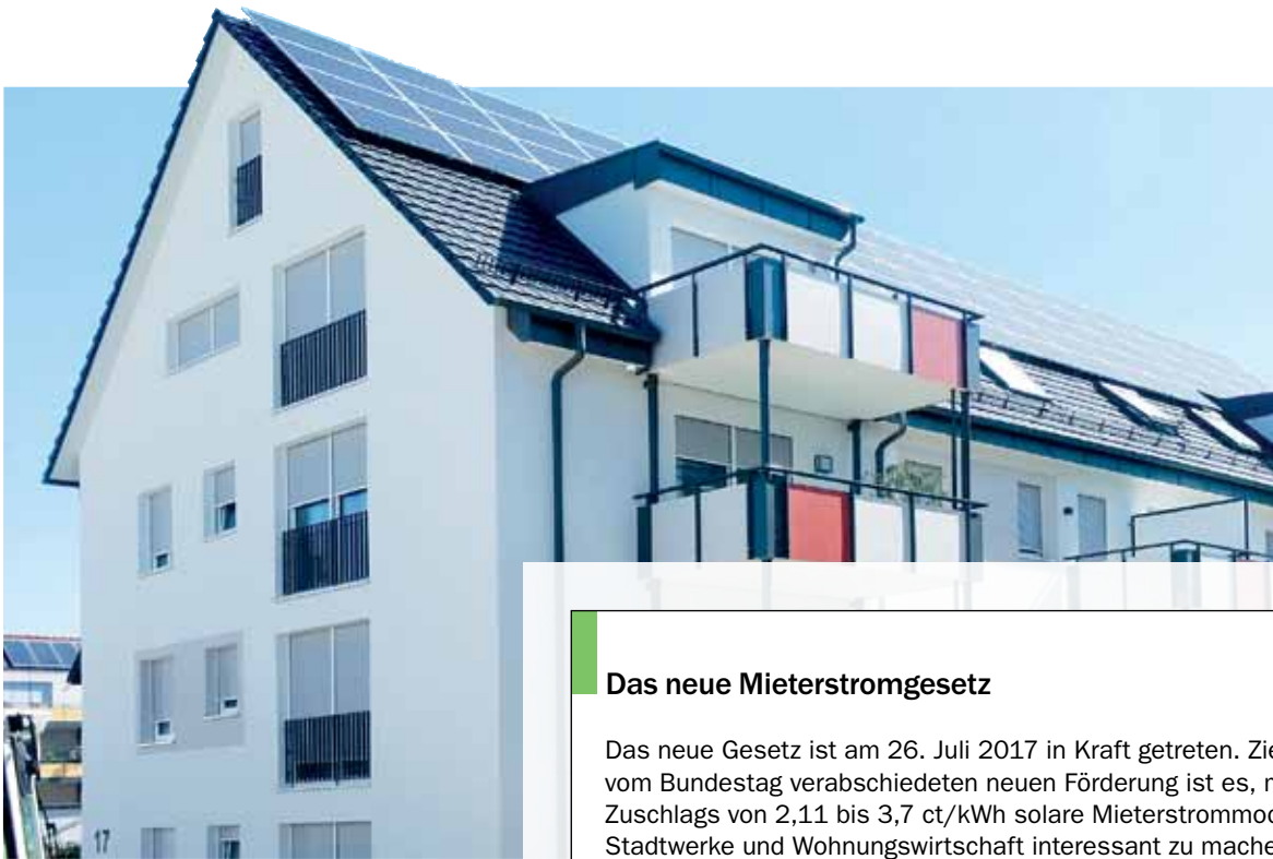
Neubau mit PV-Anlage, Mehrfamilienhaus der FEWOG in Fellbach bei Stuttgart.
